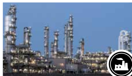
Refinarias e Petroquímicas
